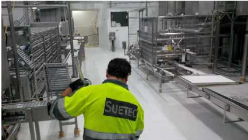
Imagen 7: Aplicación de resina de metacrilato
