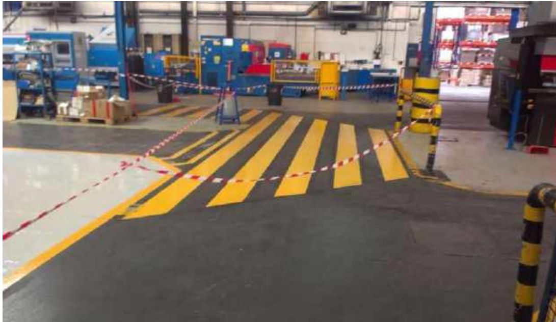
Imagen3: Pintura parking y señalización
