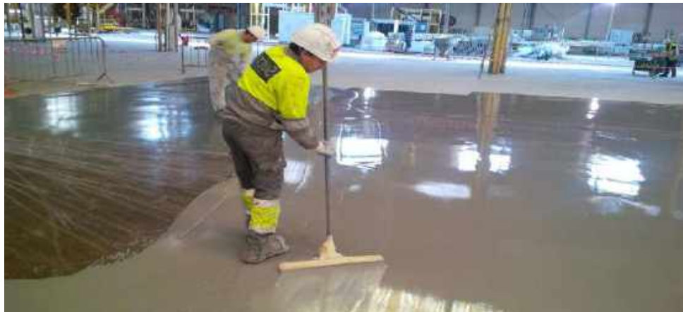
Imagen 6: Aplicación de poliuretano cemento
