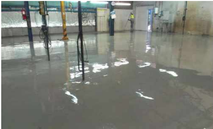
Imagen 8: Pavimento de mortero epoxi
