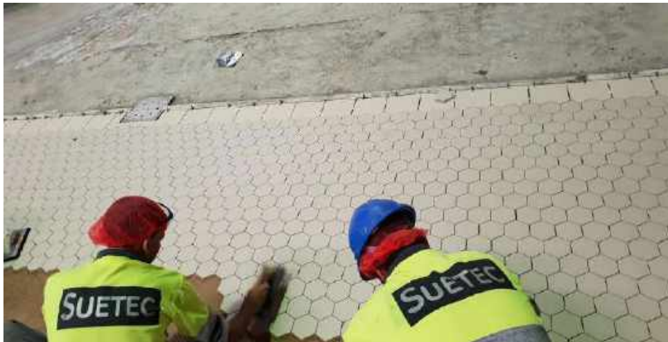
Imagen 5: Aplicación de loseta antiácida
